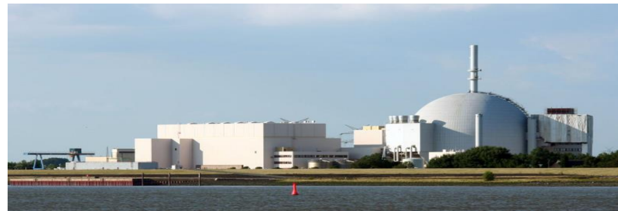
Kernkraftwerk an der Elbe
