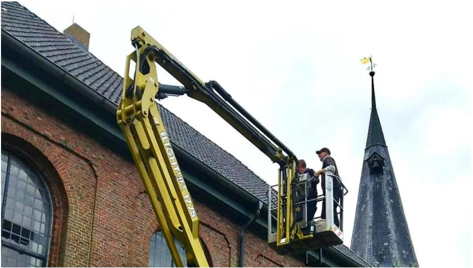
Eine verstopfte Regenrinne verursachte Feuchtigkeit im Mauerwerk. Nachdem es von unten mittels eines Hochdruckreinigers nicht geklappt hat, wurde die Verstopfung mittels eines Hubsteigers von oben behoben. Das alles durch ehrenamtliches Engagement!
